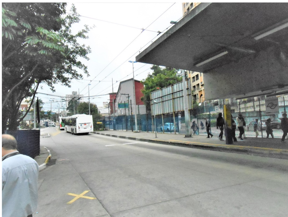
Figura 10 - Ponto deslocado sem cobertura
