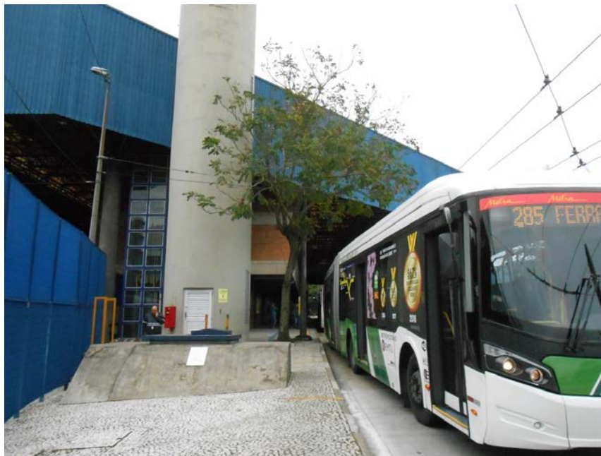
Figura 29 - Ponto sem cobertura
