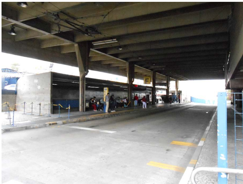
Figura 16 - Plataforma F do Terminal Piraporinha
